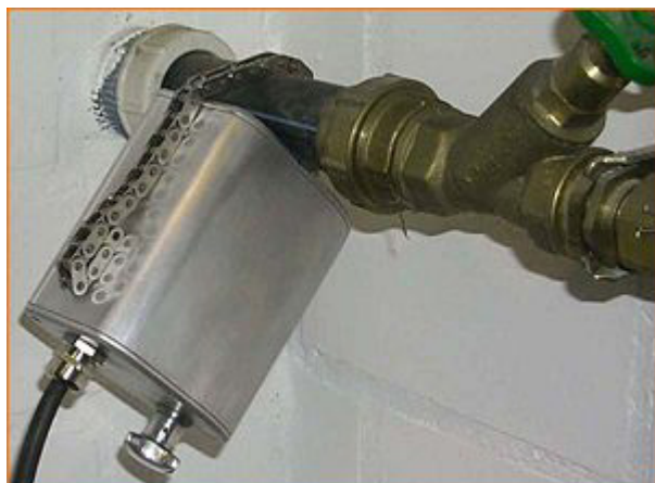
Utilisation du Vibreur P sur un branchement domestique
