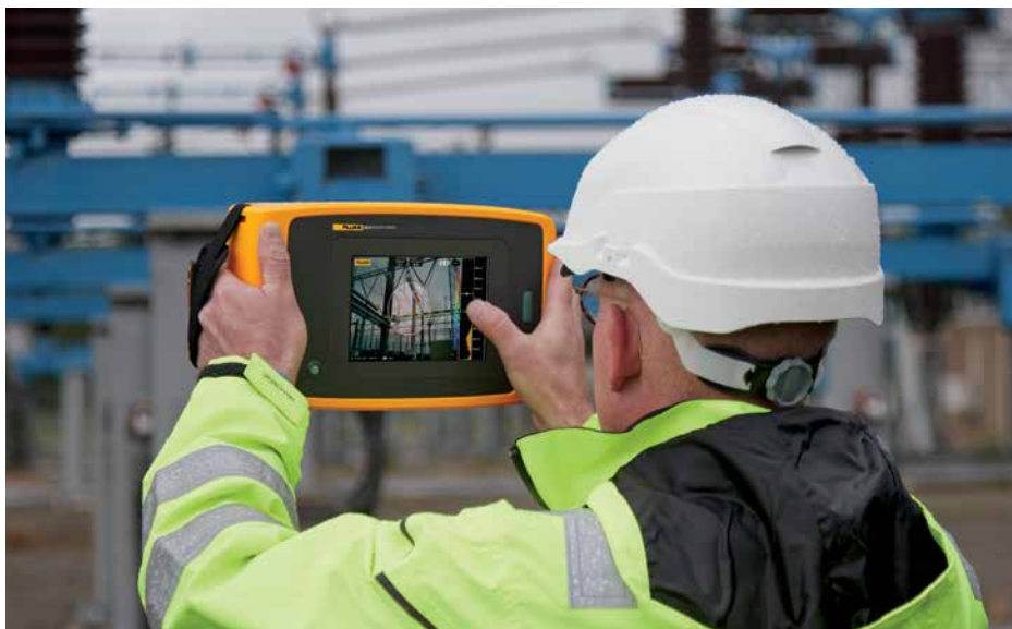
Image prise avec la caméra acoustique de précision ii910 qui détecte une décharge partielle dans une application haute tension.
