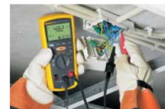
Bedradingstest in een kleine verdeelkast – alles op één enkele plek
